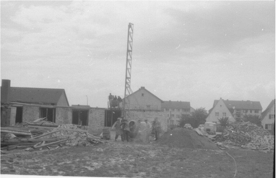
Beginn der Bauarbeiten am Gemeindezentrum 1961
