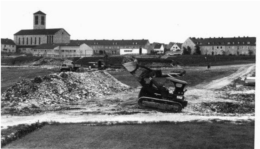
So fing es an: Beginn der Bauarbeiten 1957
