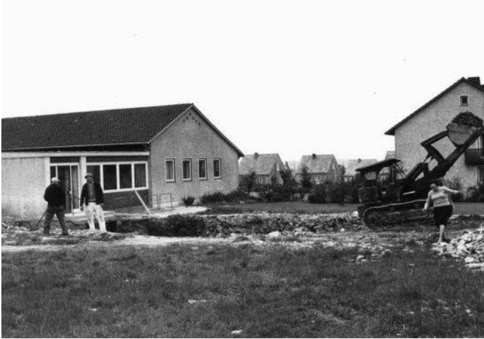
Langsam nimmt das Gelände Gestalt an (1958).
